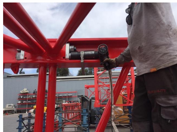
Abbildung 1: Der abgewinkelte Elektroschrauber ECWip100 von alkitronic an der Kranverschraubung.
