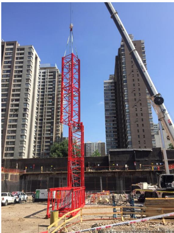
Abbildung 2: Die Arbeit im Kranbau bringt viele Herausforderungen mit sich.
