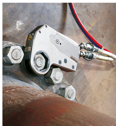
alkitronic® H-AX , beim Verschrauben eines Flansches im Anlagenbau.
